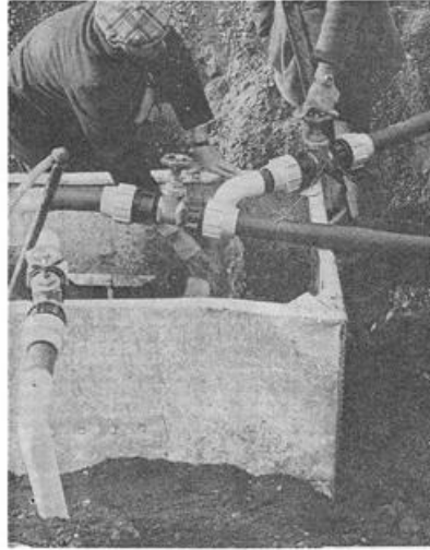
Трубы, выходящие в резервуар тестируются перед закапыванием
